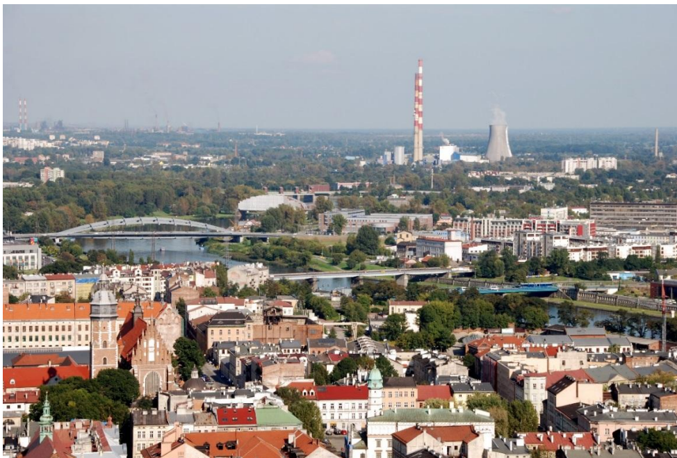
Fot. EDF Polska S.A. w Krakowie (P. Pilch)
