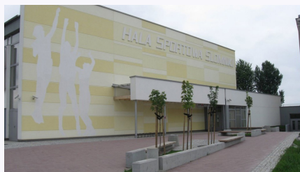
Zdjęcie 3: Pasywny budynek użyteczności publicznej – hala sportowa w Słomnikach 13
